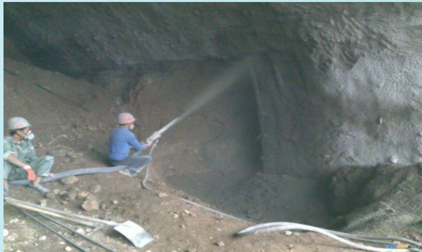
喷射混凝土施工
