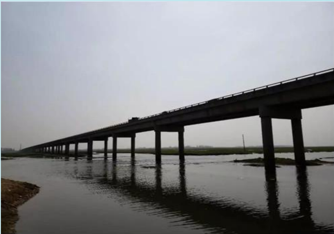
安徽阜阳中岗大桥
